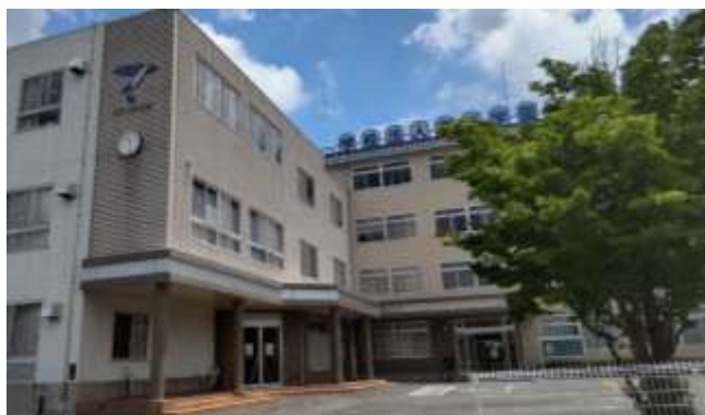
【図Ⅲ-B-1-1】正面玄関スロープ
