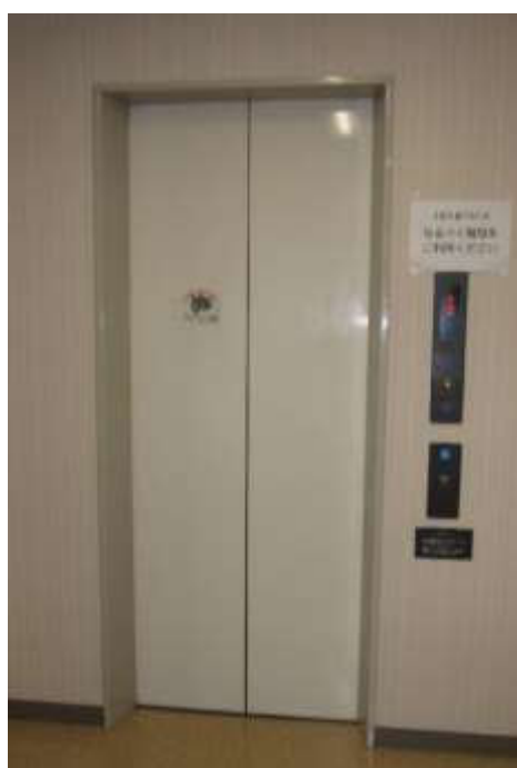
【図Ⅲ-B-1-3】エレベーター
